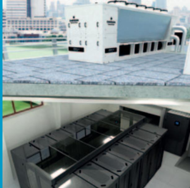
**Чиллер Liebert® HPC с естественным охлаждением и системой SmartAisle™ в сравнении со стандартной установкой**
