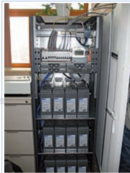
Рис. 15 Смонтированная батарея A412/120FT
