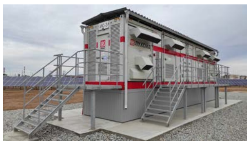
Блочно-модульная инверторная установка на объекте
