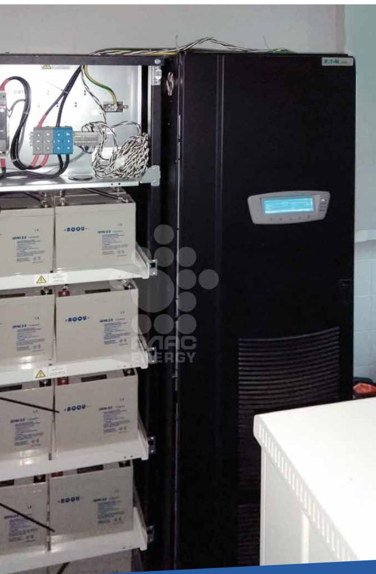
Данный проект был выполнен для защиты медицинского оборудования от кратковременных скачков напряжения в одной из Подмосковных клиник. Для определения полной установленной мощности наши инженеры, с помощью специальной аппаратуры, провели замеры энергопотребления защищаемого оборудования, а именно рентгеновского аппарата ORANGE-1040HF и рентгеноскопа типа с-дуга Carmen 9R.
