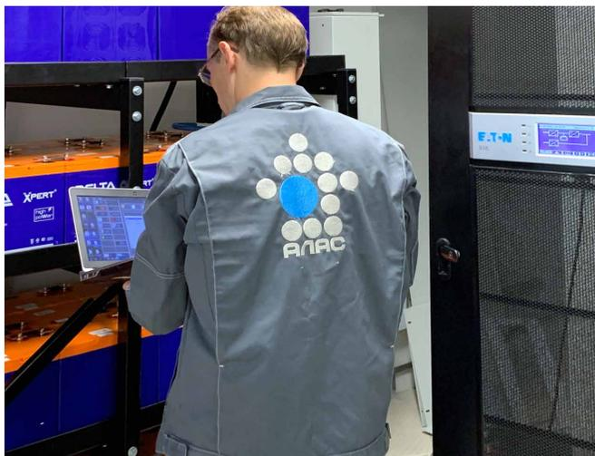
Наши инженеры с помощью специальной аппаратуры провели замеры энергопотребления защищаемого оборудования. По результатам этих замеров была выбрана подходящая модель ИБП. Осуществлена поставка двух
