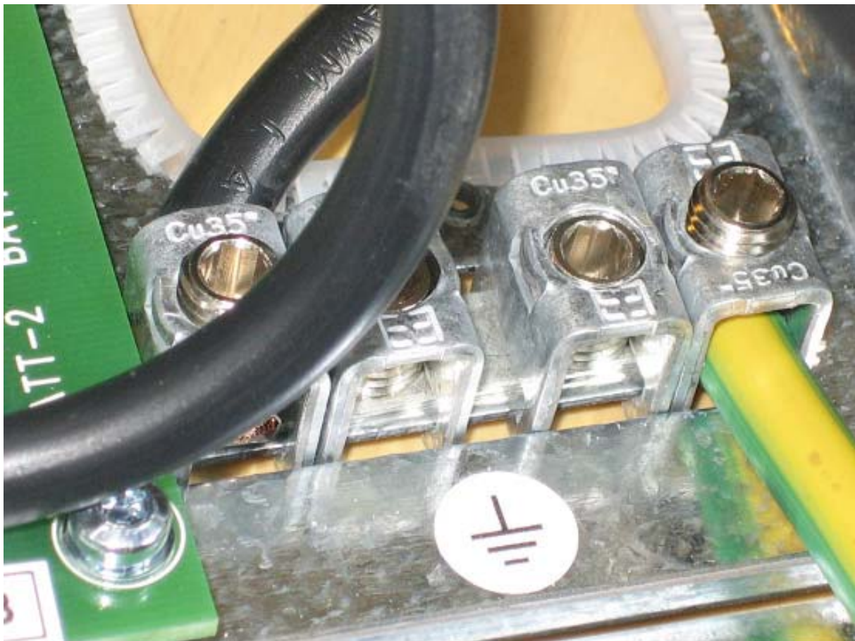
Рисунок 1 Соединение защитного проводника заземления с основанием системного модуля в нижней части
