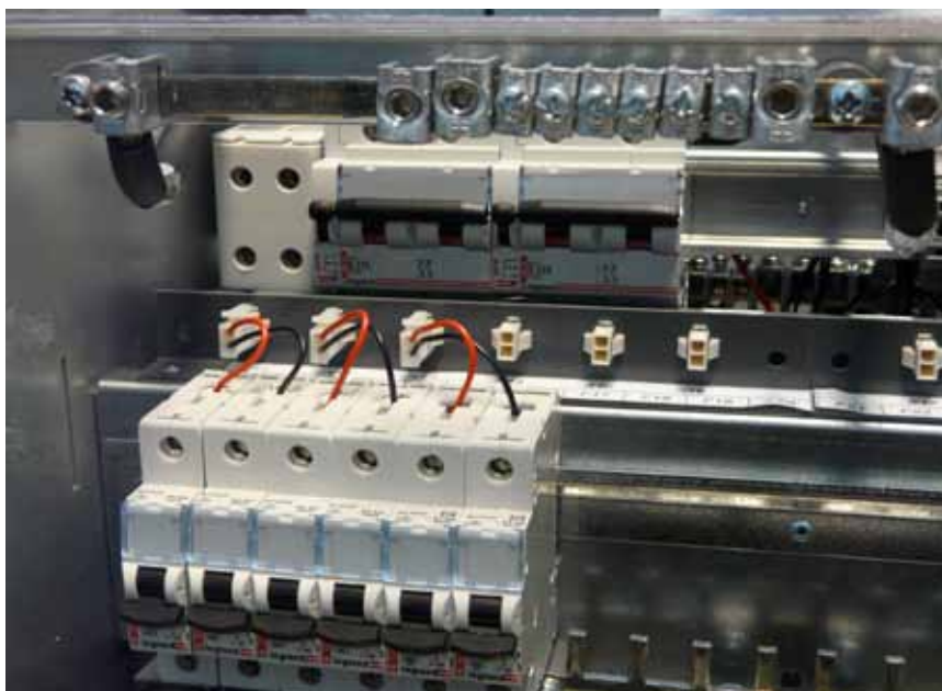
Рисунок 6. Распределение нагрузок в системе в корпусе 19" с заземленным положительным полюсом. Внизу - защитные устройства распределения нагрузки, вверху - шина нагрузки.
