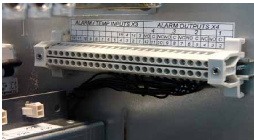
Рисунок 9. Подключение кабелей сигнализации.
