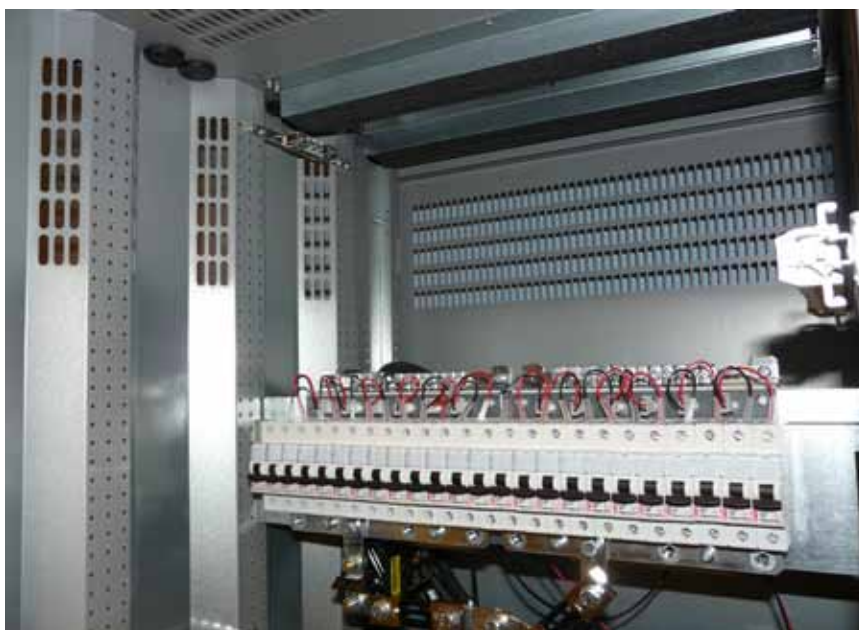
Рисунок 7. Распределение нагрузок в кабинетной системе с заземленным положительным полюсом. Внизу - защитные устройства распределения нагрузки, в верхнем левом углу - разъем для подключения рабочего заземления.
