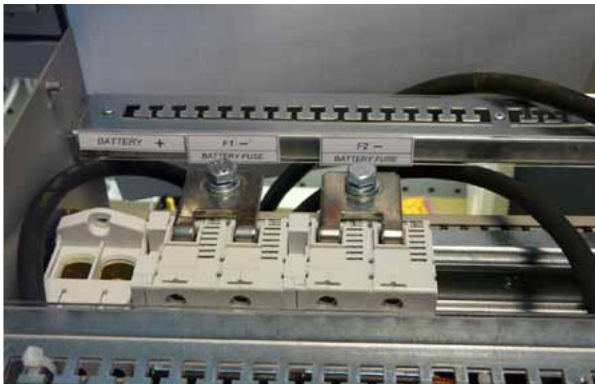
Рисунок 8. Соединения батарей.
