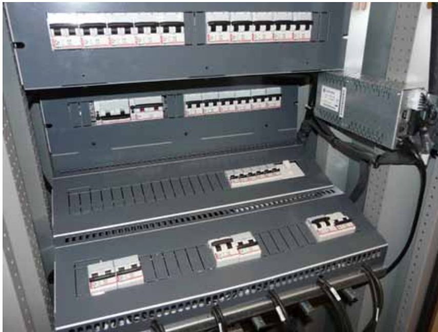
Рисунок 1. Автоматические выключатели кабинетной системы OPUS
